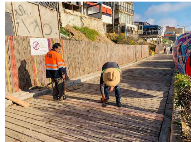
2. Mantenimiento del andador peatonal, sustitución de los tabloncillos dañados y recubrimiento con barniz especial
