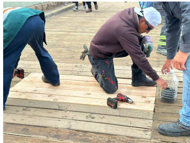
2. Mantenimiento del andador peatonal, sustitución de los tabloncillos dañados y recubrimiento con barniz especial
